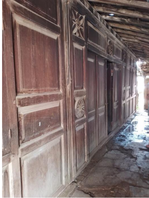
Foto 2: Dinding Kayu Bagian Depan Rumah Induk
